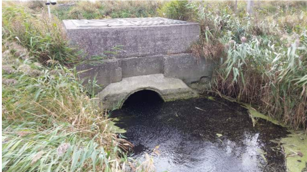
Figur 3-2 Udløbsbygværk set fra indløbssiden
